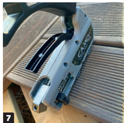
7 Monter dekket med skjulte skruer. Det gir god mening når det lages mønster som her, der det ellers ville vært vanskelig å lage rette rekker med skruer.
