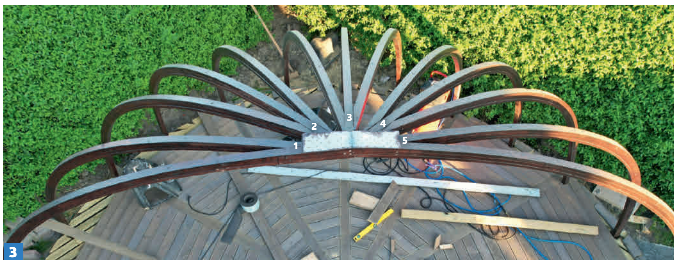
Sett sammen sperrene i fem sett, før du setter dem opp. Da blir konstruksjonen enklere å reise. Sperrene monteres sammen med et spikerbeslag i toppen når de er på plass.
