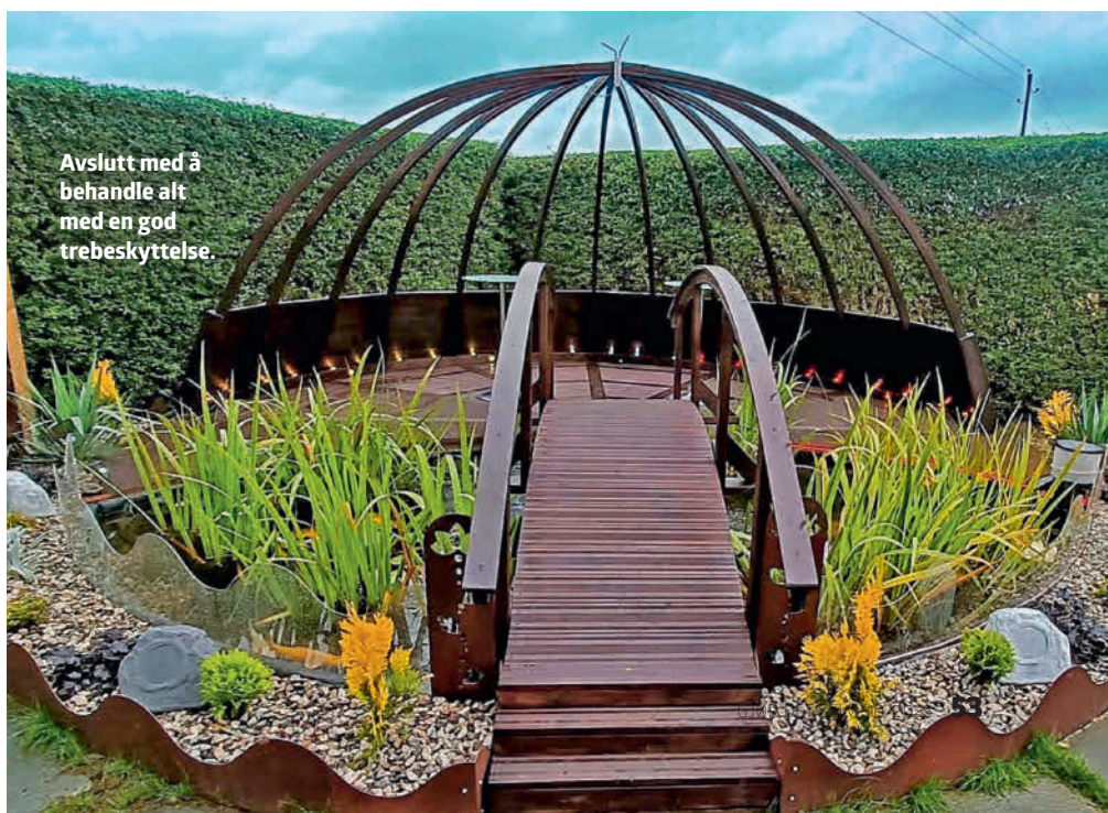
3 Lag en trapp i bunnen ved å skjære ut trekantede klosser som tilpasses buen. Etterpå kan trappen kles på samme måte som resten av broen.
