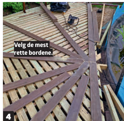
4 Del dekket inn i seks felter med sju bord som følger bjelkelagets retning. Bordene samles i gjæring i midten.
