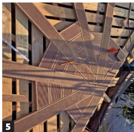
5 Fyll ut feltene med en masse skråskårede småstumper. Ha 5 mm avstand mellom bordene, og sørg for at overkantene på bordene følger hverandre.
