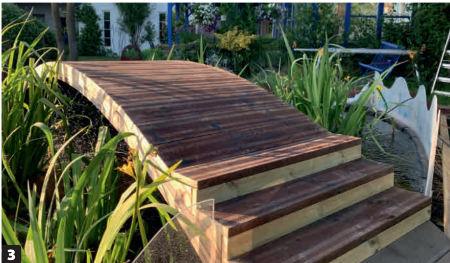
3 Lag en trapp i bunnen ved å skjære ut trekantede klosser som tilpasses buen. Etterpå kan trappen kles på samme måte som resten av broen.
