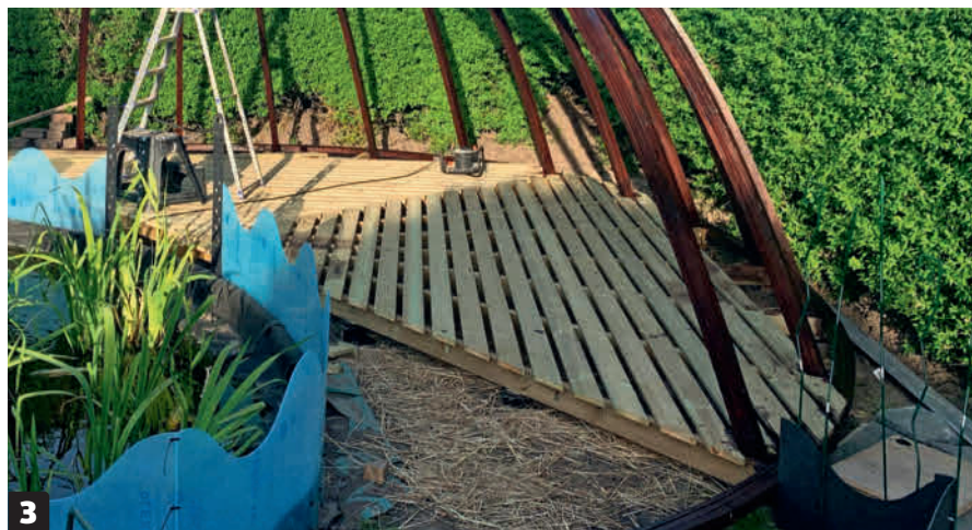
3 Lag 2 cm mellom bordene i underlaget. Det sikrer et stabilt og ventilert underlag til terrassebordene som skal danne det endelige gulvet oppå.
