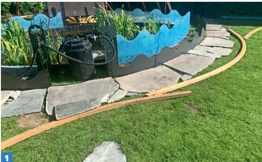
Alle de buede sperrene lages på overmål og kappes først når limet er tørt.
