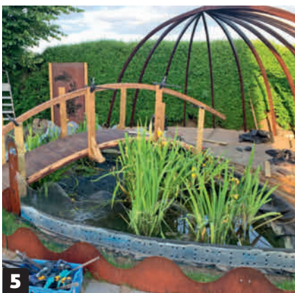
5 Kapp stolpene til i toppen, slik at den buede håndlisten kan monteres.
