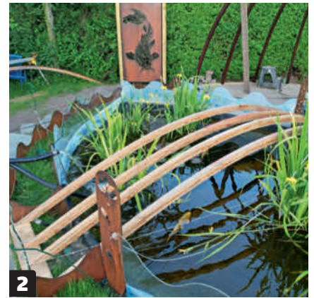
2 Kapp til de fire bøyde vangene og skru dem fast til den tverrgående bjelken som er satt fast på begge sider av broen.
