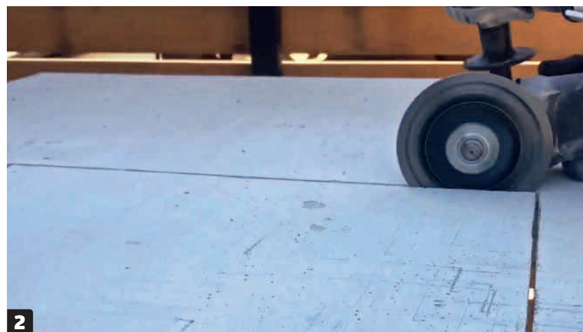
2 Leikkaa levyt. Voit käyttää leikkaamiseen kulmahiomakonetta tai käsisirkkeliä ja kuitusementtiterää. Leikkaa mahdollisimman tarkasti viivoja pitkin. Muista käyttää hengityssuojainta, suojalaseja ja kuulosuojaimia.
