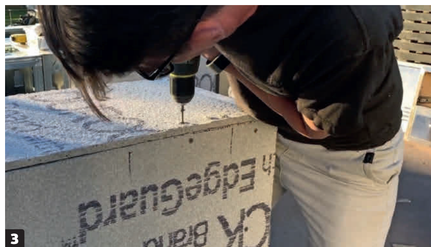
3 Ruuvaa kuitusementtilevyt kiinni runkoon. Poraat ruuveille aloitusreiät, jotta ruuvit uppoavat rankoihin helposti. Käytä kuitusementille tarkoitettuja porakärkiruuveja.
