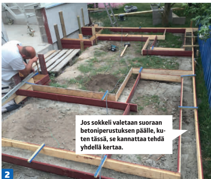
3 Suorista huolellisesti. Valetun sokkelin yläosan on oltava vaakasuorassa joka suuntaan. Jos näin ei ole, Leca-harkkoja on myöhemmin mukautettava yksitellen.
