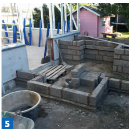
5 Rakenna kohopenkki. Myös penkin reunat koostuvat Leca-harkkoista. Tässä käytetään kapeampia harkkoja kuin talvipuutarhassa.
