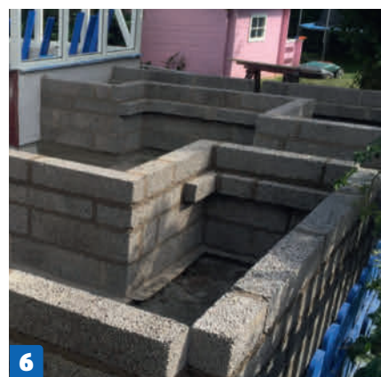
6 Tee ulkonema. Kun toiseksi ylin harkko asetetaan leveä puoli alaspäin, syntyy ulkonema, jota voidaan myöhemmin käyttää istuinpenkin alustana.
