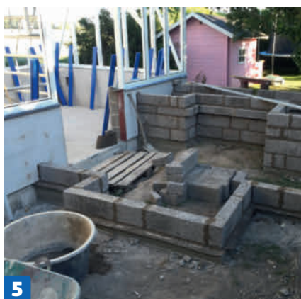
5 Bygg högbädden. "Lådans" kanter består också av lecablock. Här ställs de bara på högkant för att ge ett smalare intryck.
