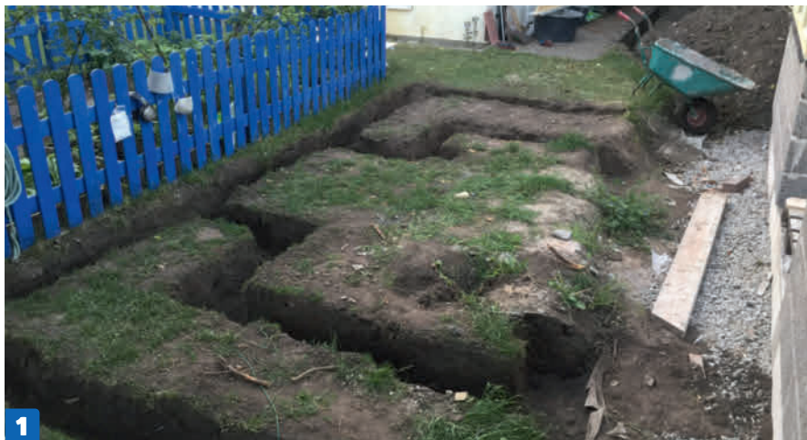
1 Gräven ränna. Börja med att göra ett randfundament, där kanten på högbädden ska vara. Gräv ner på frostfritt djup – här ca 90 cm – och gjut med betong.
