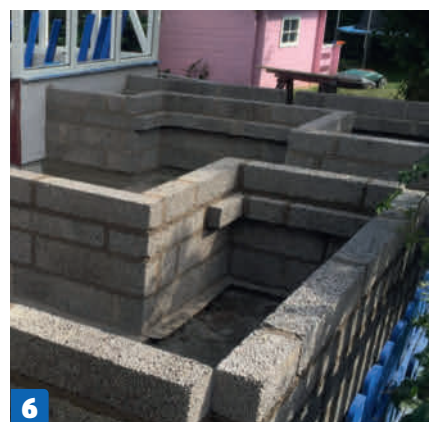
6 Gör en avsats. Genom att vända blocken i det näst sista skiftet åt andra hållet, bildas en avsats som senare kan användas som underlag till en bänk.
