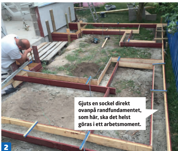
3 Jämna till noga. Ovansidan på den gjutna sockeln ska vara vågrät runt om. Är den inte det, måste lecablocken anpassas individuellt.
