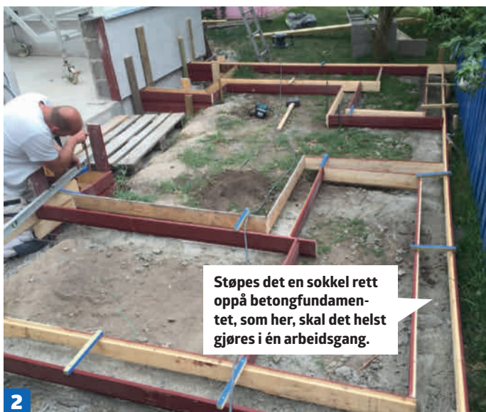
3 Rett opp grundig. Toppen av den støpte sokkelen skal være vannrett hele veien rundt. Er den ikke det, må lecablokkene senere tilpasses individuelt.
