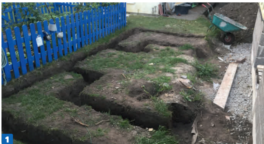
1 Graven renne. Begynn å lage et støpt fundament der kantene til høybedet skal være. Grav deg ned i frostfri dybde, og støp med betong.
