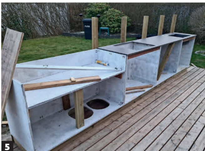
5 Elementene har fått et strøk maling på overflaten av de rå byggeplatene. I tillegg er det montert en loddrett støtte under grillbordet og loddrette støtter bak på elementene.
