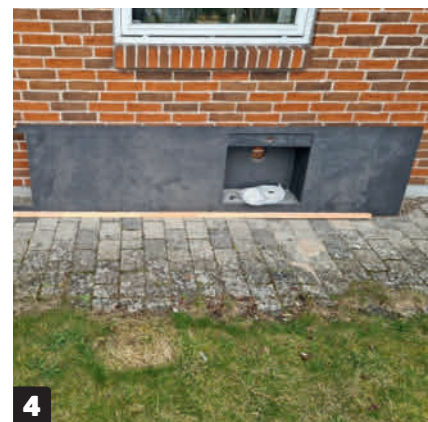
4 En brukt, værbestandig benkeplate. Utekjøkkenets eier har vært heldig og funnet en brukt komposittbenkeplate med innebygget håndvask.
