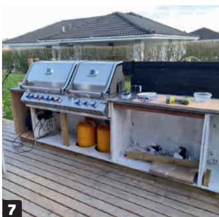
7 Gassflasker skal oppbevares ventilert. Det sørger lektekledningen for. Husk at fordi gass er tyngre enn luft, så siver den ut i bunnen.
