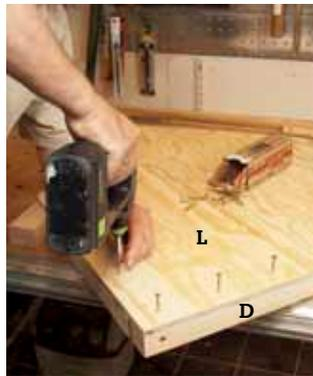
**5** Sett platene (L) og (M) fast på gavlrammene med 35 mm skruer. Hullet i platen (M), som skal være inngang til hundehuset, sages ut med en stikksag.
