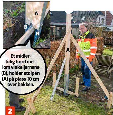
**Plasser stolpene (A)** i hullene, og sett dem midlertidig fast med skråstivere (bruk et par tynne skruer). Sett et bord med en bredde på 10 cm mellom vinkeljernene i bunnen, eventuelt med en liten vinkel, slik at stolpene holdes fast i riktig høyde over bakken.
