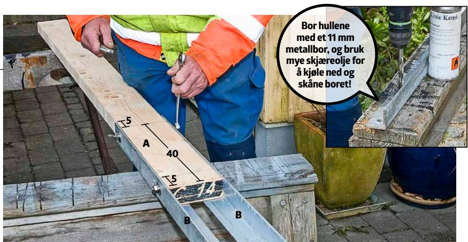
**Mål opp 40 cm fra bunnen av stolpen (A).** Forbor gjennom stolpen og vinkeljernene (B), og skru på vinkeljernene med 10 mm galvaniserte gjengestenger med muttere og skiver. Her kan du se hvordan vi har boret gjennom vinkeljernene og stolpen 5 cm fra bunnen, og igjen 5 cm fra toppen av vinkeljernene. Sørg for å spenne vinkeljernene godt fast med skrutvinger før du borer i dem – da har du bedre kontroll på boringen.
