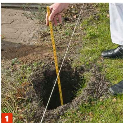
**Sett opp en snor** der leveggen skal stå. Du kan eventuelt bruke et par jordspyd eller påler til formålet. Snoren går gjennom sentrum av hullene. Her graver vi hull med 316 cm avstand. Dybden er 90 cm, og hullene er 40 x 40 cm.
