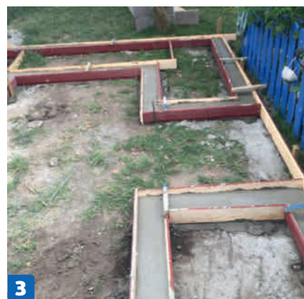
3 Ret grundigt af. Toppen af den støbte sokkel skal være vandret hele vejen rundt. Er den ikke det, skal lecablokkene tilpasses individuelt.
