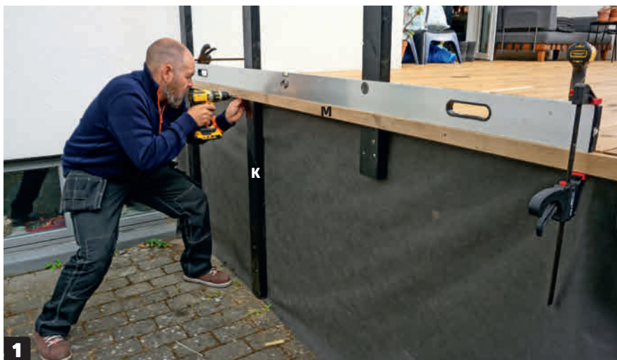
1 Ensimmäinen rima (M) asetetaan siten, että se on samassa tasossa terassin lattian kanssa. Varmista, että se on täysin suorassa. Tämä helpottaa seuraavien rimojen asennusta.
