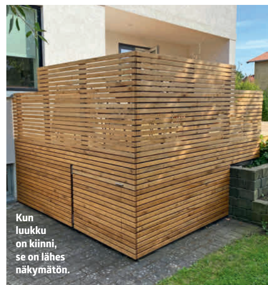
4 Mittaa luukku saranoista kulmaan asti. Leikkauskohta tulee sijoittaa noin 2 millin päähän luukun pystysuorasta reunasta. Tarkista vesiväällä, että leikkauskohta on pystysuorassa ja seuraa luukun sivua.
