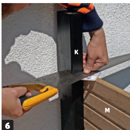
6 Katkaise tolpat (K) pituussuunnassa rimaverhouksen (M) asennuksen jälkeen. Se onnistuu helposti käsisahalla. Aseta välikappale ylimmän rimaa reunan, jotta sahasta ei jää jälkeä.
