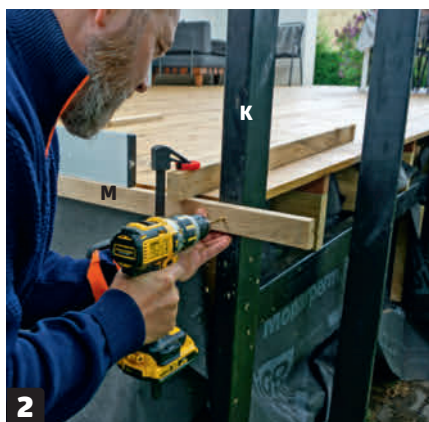
2 Rima (M) ruuvataan kiinni tolppiin (K), kun se on oikein paikallaan. Kiinnitys tarvittaessa lista terassilattian päälle mittamerkiksi ensimmäiselle rimalle.
