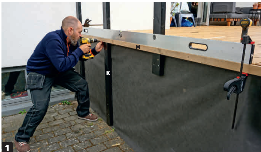
1 Den första ribban (M) sätts upp i höjd med trallbrädorna. Var noga med att sätta den helt rakt. Då blir det mycket enklare att sätta de nästkommande ribborna också.
