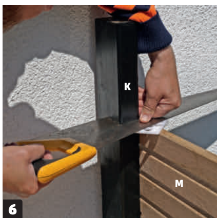
6 Kapa stolparna (K) på höjden när du är färdig med ribbpanelen (M). Det kan du göra lätt med en fogsvans. Lägg en distanskloss på den översta ribban, så att du inte gör märken i den.
