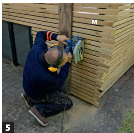
5 Luckan sågas fri så att den kan öppnas in till utrymmet under trädäcket. Här används en sänksåg och en lång, rak bräda. Snittet i de genomgående ribborna är nästan osynligt. Därefter sätts återstående ribbor.
