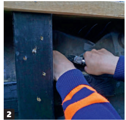
2 Duken stiftes fast med stiftemaskin. Det er enkelt og raskt. Vær særlig nøye der vannet renner av. Sørg for at det ikke renner ned i konstruksjonen.
