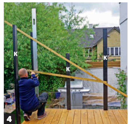
4 Rett opp stolpene (K) så de står i lodd, med nøyaktig samme avstand mellom dem. Hold stolpene midlertidig fast med for eksempel et par hjelpebord.
