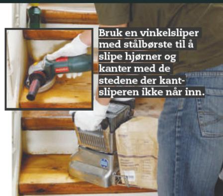
**2** Slip trinnene med en kantslipper. Den kan leies i utleiebyråer og i noen byggevarehus, men alternativt kan du bruke vinkelsliperen – men resultatet blir da ikke på langt nær så pent. Bruk alltid støvmaske når du sliper.
