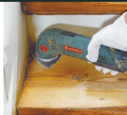
**3** Slip helt inn i hjørnene og langs kantene med deltasliperen. Begynn med grovt slipepapir som for eksempel korn 40. Ei malingsskrape kan også gjøre jobben hvis du ikke har en deltaslipper i verktøykassa.
