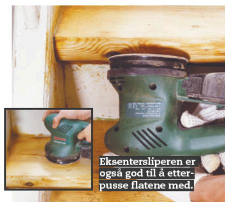
**4** Slip framkantene med eksenter-sliperen. Begynn med grovt slipepapir som for eksempel korn 60, og slip etter med finere kom. Avslutt med å slipe alle flatene med korn 180.
