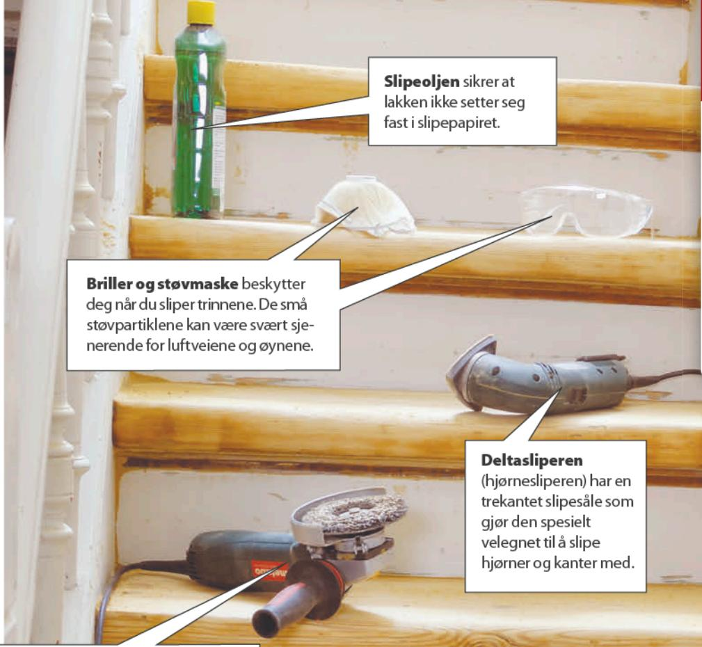
**Vinkelsliperen med stålborste** tar det øverste laget med lakk der kantsliperen ikke når inn. Det er viktig at du bruker vinkelsliperen før du sliper med deltasliperen. Ellers brenner lakken seg fast.
