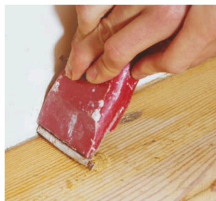
**5** Skrap det siste stykke mot opptrinnet med ei malingsskrape. Sjekk at all lakken er fjernet fra trinnene.
