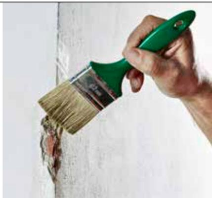
**1** Børst skaden fri for støv og løst puss. Fukt med vann, slik at mørtelen får god vedheft til underlaget. Du kan eventuelt legge litt sement i vannet for å sikre en enda bedre vedhefting.
