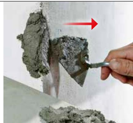
**2** Fyll opp skaden. Legg mørtel på et pussebrett. Ta deretter litt og litt på baksiden av en murskje, og fyll skaden. Legg det på fra hjørnet og inn mot veggen. Fyll på slik at det blir rikelig med mørtel.
