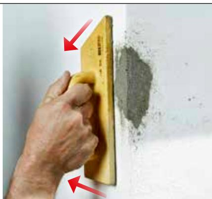
**4** Glatt veggen med pussebrettet når bordet er fjernet. Beveg bordet fra hjørnet og inn på veggen i små, forsiktede bevegelser. Pass på at du ikke trykker mørtelen ut mot hjørnet. Glatt eventuelt etter med litt vann på en pensel.
