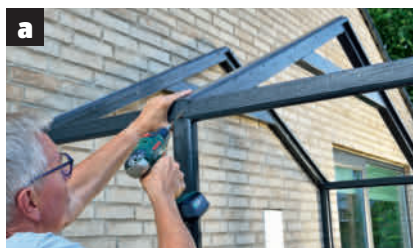
a. Ruuvaa toinen ristikko kiinni sivuseiniin 5x80 millin ruuveilla. b. Ruuvaa väliaikainen apurima kiinni ristikoihin , jotta niiden välinen etäisyys pysyy sopivana.
