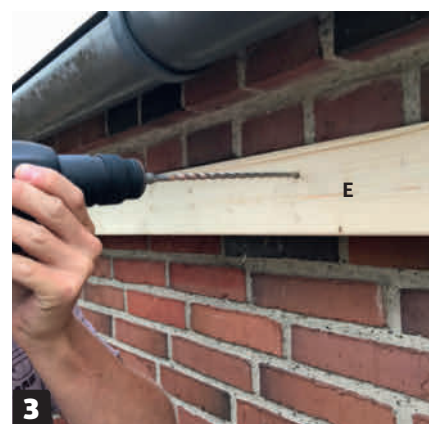
3 Poraa tiiliin, älä saumoihin. Mittaa kunnolla, ennen kuin aloitat. Kiinnitä palkki seinään 7,5 millin ankureilla noin puolen metrin välein.
