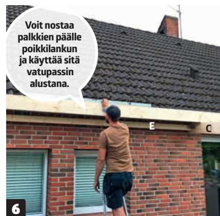
6 Tarkista, että reunimmaisii palkit (C) ovat yhtä korkealla. Käytä vatupassia ja säädä korkeutta nostamalla tai laskemalla etupalkkia.
