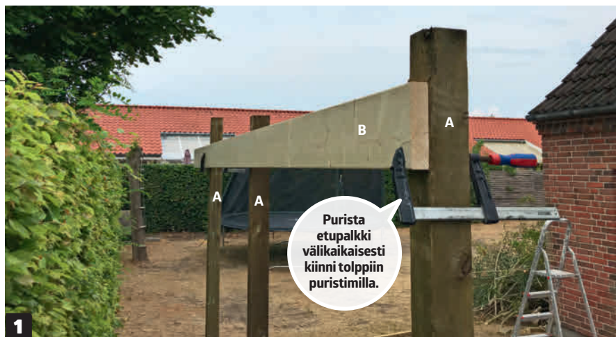
1 Purista etupalkki (B) kiinni tolppiin kutakuinkin oikeaan korkeuteen. Palkin korkeutta on helppo hienosäätää myöhemmin puristinten avulla.
