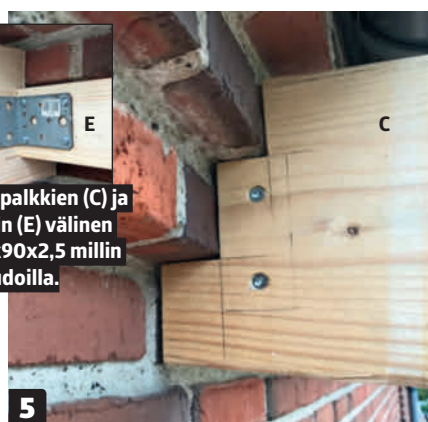
5 Ruuvaa reunimmaisii palkit (C) kiinni takapalkin (E) päihin kahdella 5,0x100 millin ruuvilla.
