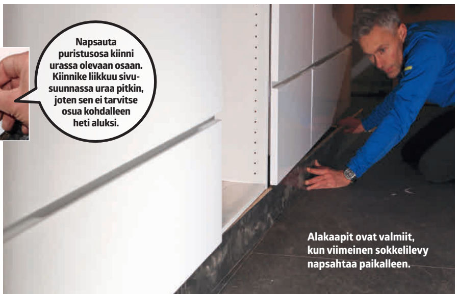
3 Lyö säätöjalan toinen puolisko sokkelilevyn takana olevaan uraan.
