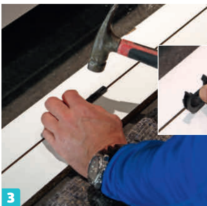
3 Lyö säätöjalan toinen puolisko sokkelilevyn takana olevaan uraan.
