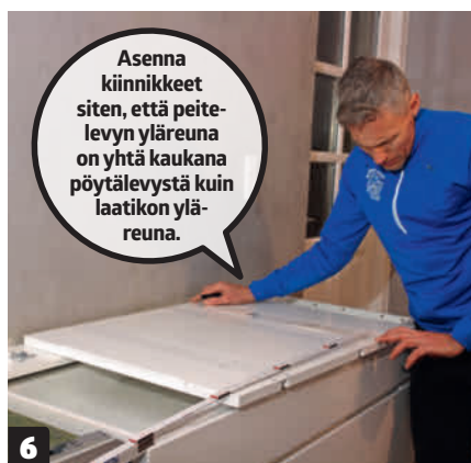
6 Merkitse astianpesukoneen peitelevyn taakse, mihin kohtiin kiinnikkeet pitää asentaa. Mittaa aluksi ylimmän laatikon ja pöytälevyn välinen etäisyys.
