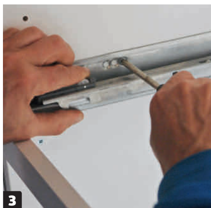
3 Ruuvaa liukukiskot kiinni kaapin seiniin. Kokenut kalusteasentaja kiinnittäisi kiskot jo ennen kaappien kokoamista. Kiskojen asentaminen on kuitenkin selkeämpää, jos se tehdään vasta tässä vaiheessa.
