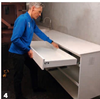
4 Asenna laatikot paikoilleen. Tarkista, että laatikot liukuvat perille asti.
