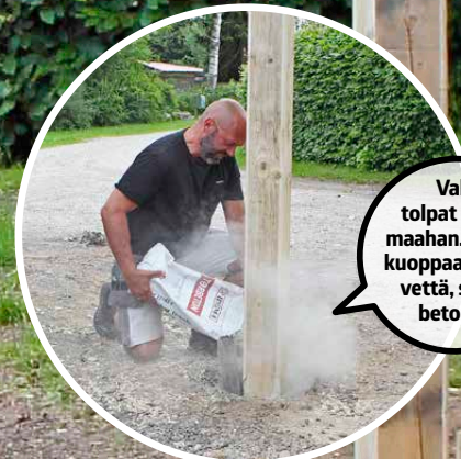
Tarkista vatupassilla, että tolpat (A) ovat aivan suorassa. Kun kaikki on kunnossa, tue tolpat betonin kuivumisen ajaksi.
