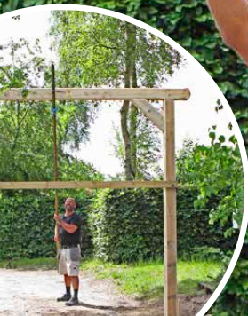
Portin pystyttämiseksi kannattaa käyttää apuna ylähirteen kiinnitettyä lautaa.
