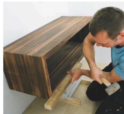
**5** Den siste biten må vi slå kassa inn over skruene med en kloss og en hammer. Det er nok til å holde kassa inne på skruene senere.
