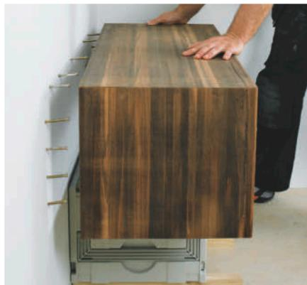
**4** Kassa dyttes forsiktig inn over skruenhodene. Sjekk at alle skruene er ut for et hull før du presser. Sitter en av dem litt skjevt, kan de skape mye trøbbel.
