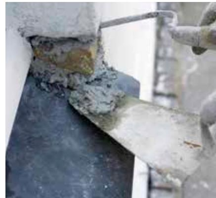
**5 Fyll på mørtel med en fugeskje,** og sorg for at fugens høyde mellom steinene tilsvarer resten av fugene i murverket. Det er spesielt viktig hvis fugene er helt eller delvis synlige.
