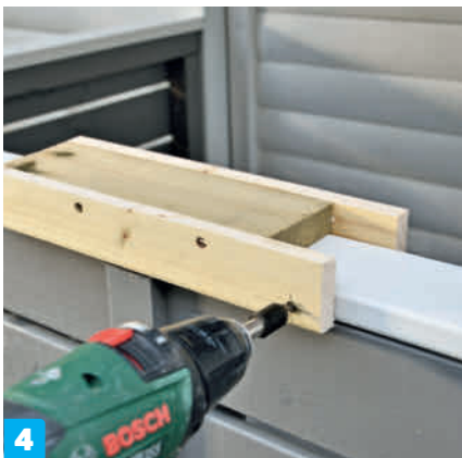
4 Asenna lukko ruuveilla. Aseta lukko paikalleen ovien päälle ja ruuvaa se kiinni kahdella 4x50 millin ruuveilla. Älä kiinnitä lukkoa liian tiukasti.
