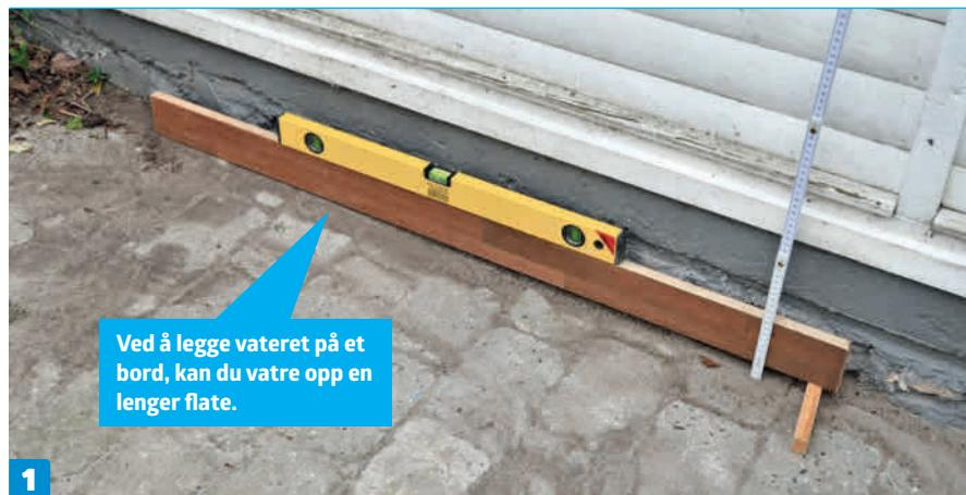
Sjekk om underlaget er jevnt der skjulet skal stå. Hvis ikke, så mål høydeforskjellen med et oppklossen vater. Legg til forskjellen i lengde på stolpen i den siden underlaget er lavere.
