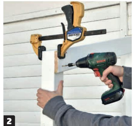
**2 Skru fast de skrå bordene (H).** Skru dem på stolpene med 4,0 x 50 mm skruer. Bruk to eller tre skruer i hver ende.
