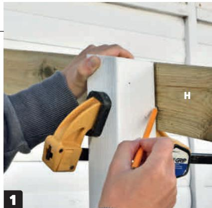
**1 Hold de skrå bordene (H) på plass med en tvinge.** Tegn opp det skrå snittet, og kapp deretter bordet slik at forkanten flukter med stolpen.
