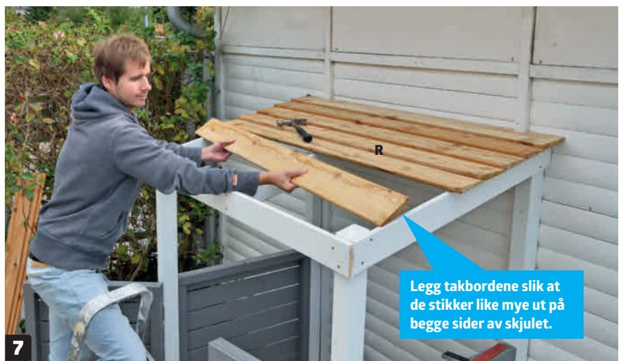
**7 Kapp til takbordene (R),** og spikre dem deretter fast til takrammen med 1,7 x 35 mm galvaniserte spiker. Takbordene skal legges med et lite overlapp.
