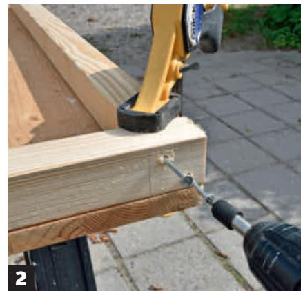
**Skru sammen rammene.** Du skal bruke 5,0 x 90 mm skruer til å skru dem sammen. Forbor med et 5 mm bør, og sørge for at de lange skruene ikke går skjevt – da risikerer du at de kommer ut på siden av rammen.
