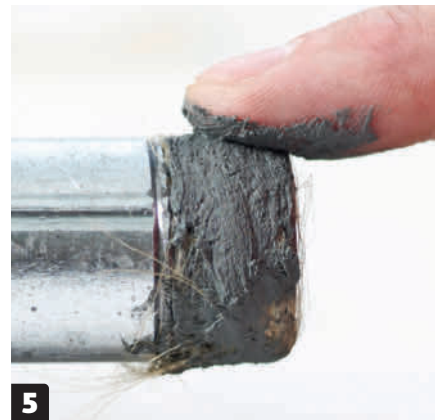
2 Vikle et stykke pakkgarn rundt gjengene. Det skal ligge som et tynt lag jevnt over alle gjengene. Blir laget for tykt, blir det presset av når du skrur sammen delene.
