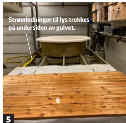
**28 x 120 mm terrassebord (B) legges som gulv** på rammen. Under badstuedelen av terrassebordene legges en vindsperr. Bakerst under rammen er det også satt på en ekstra hjulaksel (synes ikke på bildet).
