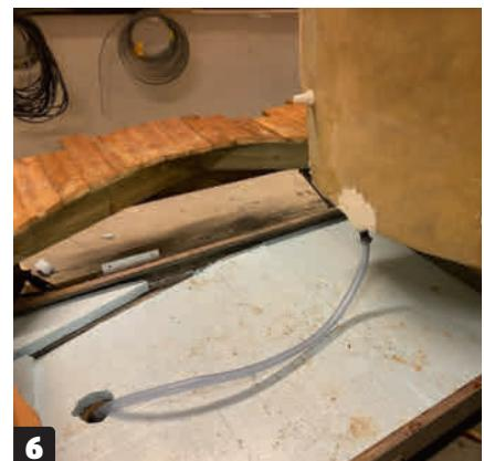
**På undersiden av glassfiberkaret** legges en isoporplate, for å isolere det fra undersiden. Det lages hull i isoporen til slangen som brukes til å tappe ut vann fra karet.
