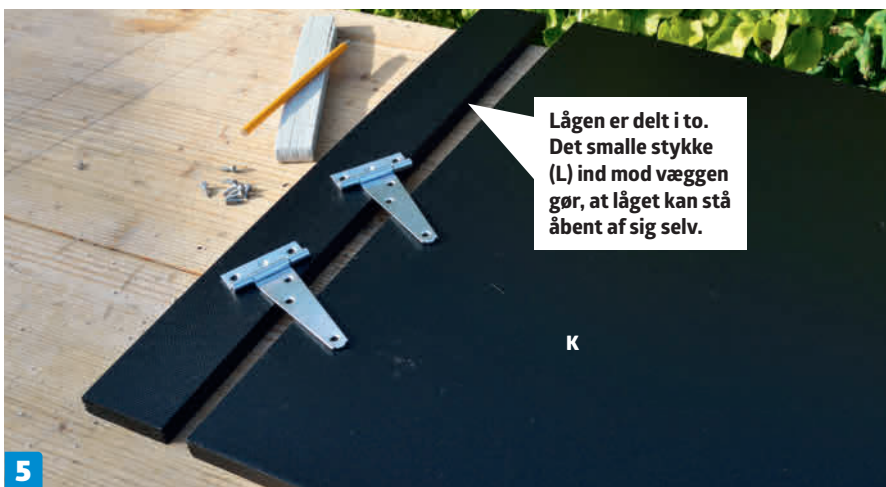
2 Låg og sider males med rulle. Kanterne skal også beskyttes med maling. De suger relativt meget, så vær opmærksom på at mætte dem godt.
