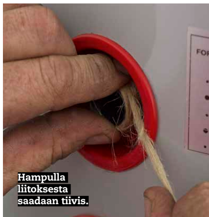
Tiivistesrasva helpottaa osien kiertämistä toisiinsa vielä vuosienkin kuluttua.
