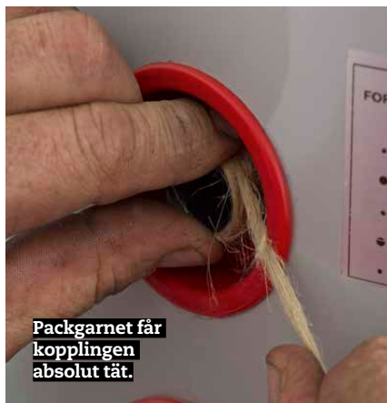
Packsalvan gör det möjligt att skruva isär kopplingen efter flera år.
