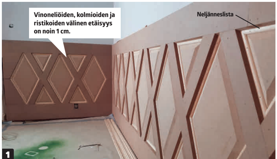
1 Vinoneliöiden ja kolmioiden ympärillä olevaan rakoön asennetaan 13 x 13 millin neljänneslista. Se helpottaa maalaamista ja luo siistit liitoskohdat paneelin osien välille.
