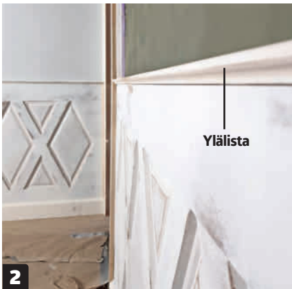
2 Asenna ylälista siten, että se on linjassa MDF-reunan eikä seinän kanssa. Jos listan ja seinän välissä on rako, se tiivistetään akryylimassalla.
