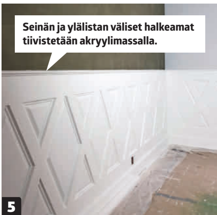
5 Rintapaneeli voidaan maalata saumauksen, tasoituksen ja pohjamaalauksen jälkeen. Suosittelemme maalia, jonka kiiltoaste on vähintään 40.
