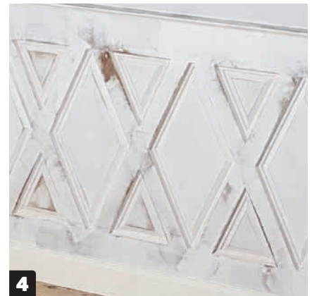
4 Kaikki liitokset tasoitetaan puulle tarkoitettulla täyteaineella. Täyteaine on hiottava ja tasoitettava vähintään kaksi kertaa. Käsittele sitten kaikki puupinnat pohjusteella.
