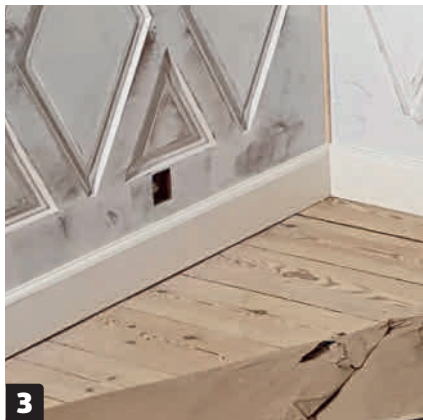
3 Lattiaa vasten asennetaan esimaalattu 15 x 91 mm jalkalista. Se painetaan tukevasti lattiaa vasten ja kiinnitetään suoraan MDF-levyyn liimalla ja nautoilla.
