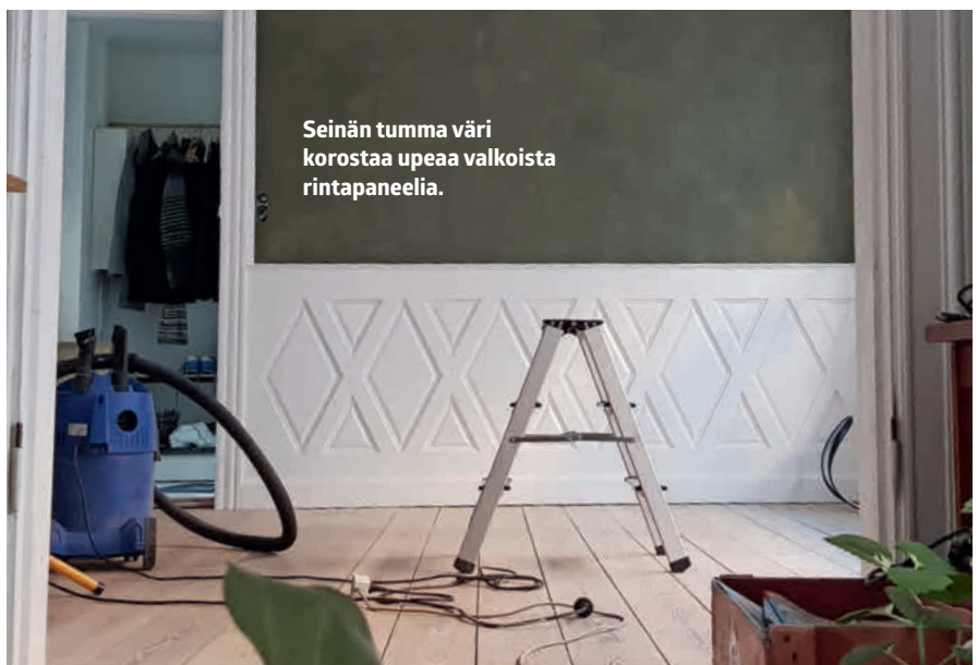
3 Lattiaa vasten asennetaan esimaalattu 15 x 91 mm jalkalista. Se painetaan tukevasti lattiaa vasten ja kiinnitetään suoraan MDF-levyyn liimalla ja nautoilla.
