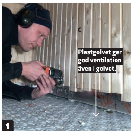
Bastupanelen (C) kapas i en rak linje längst ner för att göra plats så att isolering, regler (E) respektive trallbrädor (D) kan läggas in under panelbrädorna.
