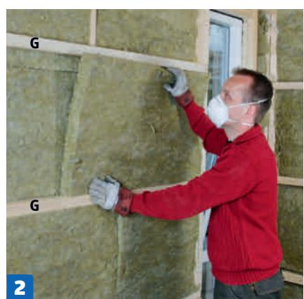
**2 Imellem reglarne (G) lægges isoleringsmåtter.** Afstanden mellem reglarne svarer til en isoleringsmåtte minus 1 cm, så de er lette at sætte i spænd. Uden på reglarne lægges endnu et lag isolering.
