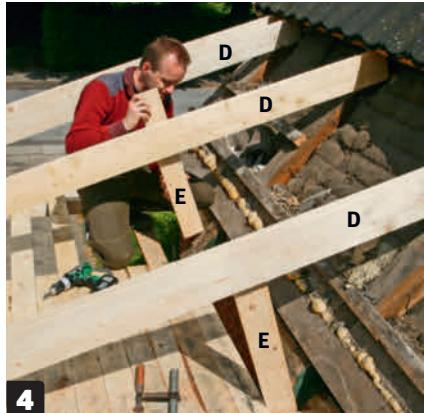
**Mellom sperrene (D) og de underliggende bjelkene (C) skrus det på avstivende tenger (E). De består av 23 x 98 mm bord, som skrus fast med 5 x 60 mm skruer.**
