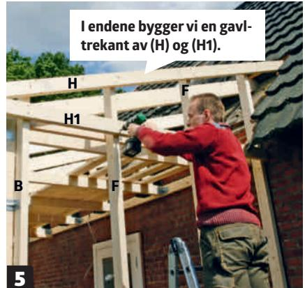
**Monter de øvrige stenderne (B) med maksimalt 80 cm mellomrom. De bærer kledningen ut- og innvendig. Stenderne til vinduene venter vi med.**
