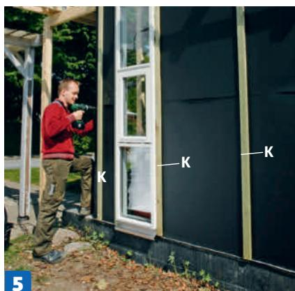
**Nu kan der monteres vindpap og afstandslister (K)** på alle vægge. De lodrette lister sørger for ventilation bag de vandreliggende beklædningsbrædder.
