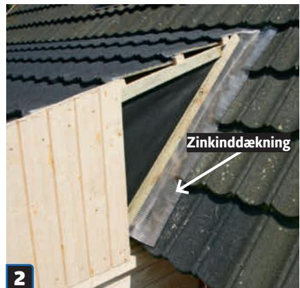
**2 I overgangen mellem vindfang og husets tag** sømmes en inddækning i zink, før de sidste brædder slås på. Den skal sikre, at der ikke kan løbe vand ind i samlingen.
