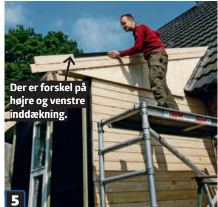
**5 Langs gavltrekantens overside** sættes vindskederne: to brædder sat sammen med fer og not. Oven på vindskederne lægges inddækninger, der er designet til Decra-taget.
