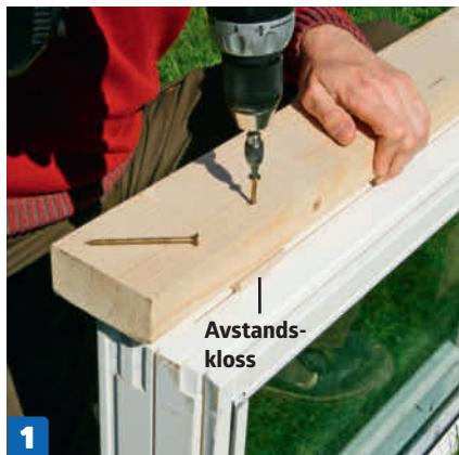
**Før stenderen (B) skrus fast til vinduets langsider**, stiftes fire 10 mm avstandsklosser fast. Det sikrer plass til en fuge. Stenderne skrus fast i flukt med avstandsklossene. Gjenta dette på vinduets andre langside.
