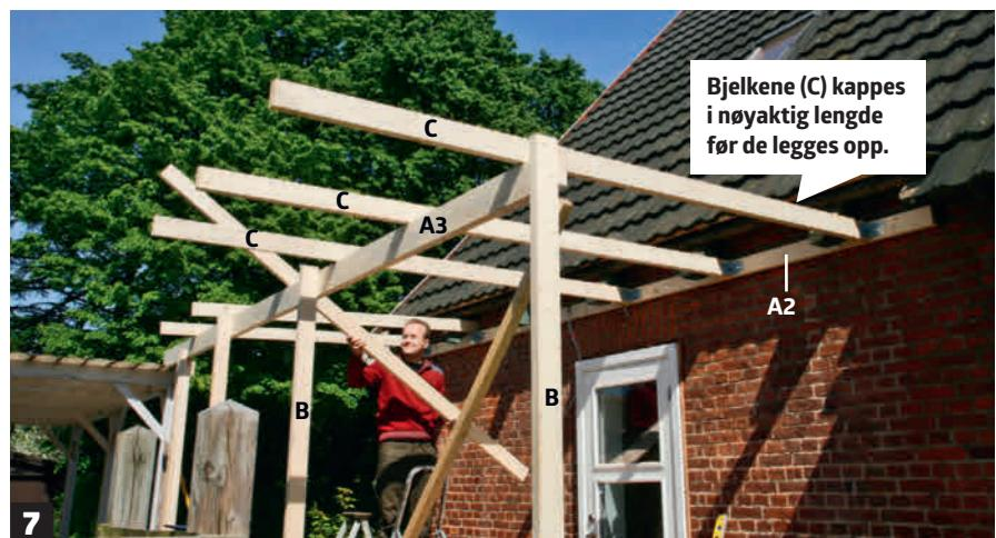
**7** **På de to øverste svillene (A2 og A3) settes bjelkene (C) fast** ut for hvert av sperrene på huset. På veggsvillen (A2) festes de i vinkelbeslag. På toppsvillen foran (A3) legges de oppå og skrus også fast med vinkelbeslag.
