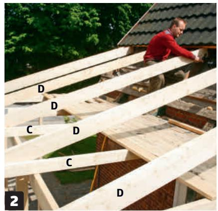
**Mellom endene på bjelkene (C) og sperrer til huset, som nå er frilagt, monteres de nye sperrene (D). Vi skrur dem fast på siden av husets sperrer med 5 x 90 mm skruer.**
