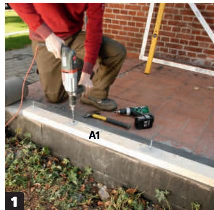
**1** **Langs fundamentets ytterkant** skrur vi fast en bunnsvill (A1). Forbor med et 10,5 mm bor, og sett fast svillen med 10 x 115 mm karmskruer. Det litt større hullet lar borestøvet slippe unna.
