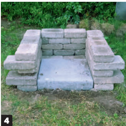
4 Stapla 3-4 skift sten ovanpå varandra. Se till att det blir rakt, och kom ihåg att varje skift skal förskjutas, så att stenarna ligger stadigt i förband.
