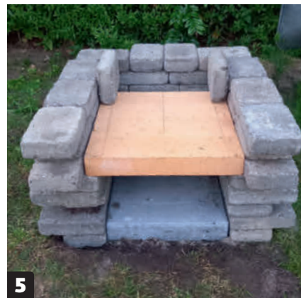
5 Markera stenarna löpande när ugnen provbyggs. Det gör det mycket enklare om den sedan ska tas ner och muras upp.
