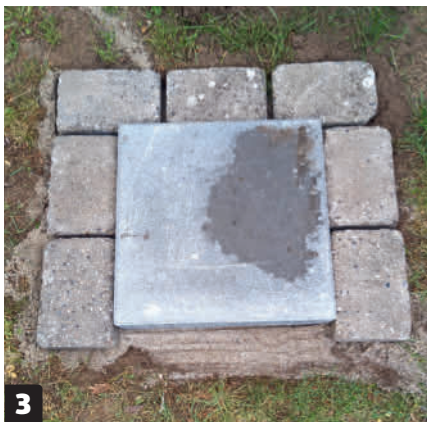
3 Det första skiftet läggs ut så att fogarna mellan stenarna blir någorlunda lika breda. Det är inte viktigt att det blir exakt. Försök att få det att passa med hela stenar, så att du måste kapa så lite som möjligt.
