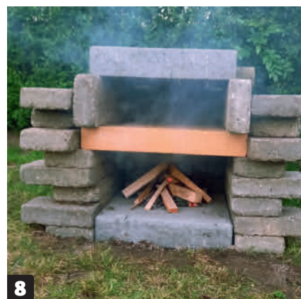
8 Låt ugnen stå som den är och fyll otät-heter med bruk. Du kan också plocka ner den för att mura upp den. Det finns också en möjlighet att täcka över hela ugnen med jord för att tätta den.
