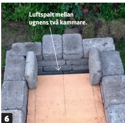
6 Den eldfasta stenen läggs på. Mellan ugnens bakre vägg och den eldfasta stenen görs ett mellanrum på ca 10 cm som bildar en kanal mellan de två kamrarna.
