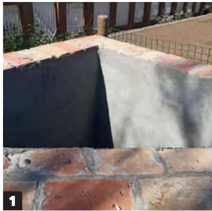
1 Rappaa laastilla polttopuiden säilytystilan sisäpinnat muurauksen suojaamiseksi.
