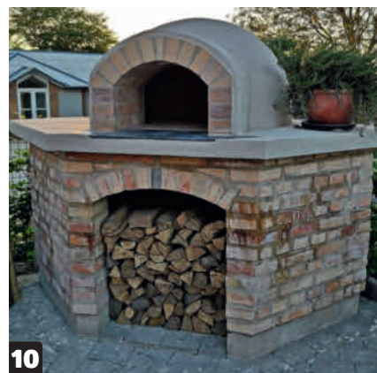
Kun uuni on muurattu valmiiksi, sen on parasta antaa kuivua vähintään 30 päivää.
