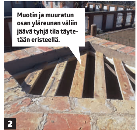
2 Betonilevy valetaan paikalleen. Aloita tekemällä muotti uunin jalustan päälle. Rimat ruuvataan muuraukseen, ja laudat asetellaan poikittain.
