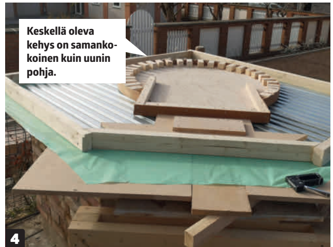
4 Aseta eriste ja muovi muotin päälle. Aaltolevyt asetetaan myös jalustan päälle. Lisäksi tehdään reunamuotti, jota tuetaan levyillä.
