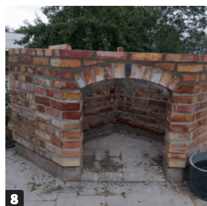
6 Opmuring med udvendige og spidse hjørner kræver altså lidt erfaring og kendskab til murværket, men hvis du gør dig umage, er det ikke umuligt.
