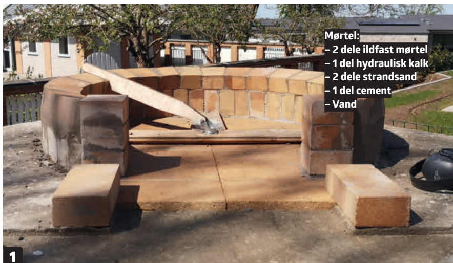
1 Den første sten, der sættes, er en halv sten, der er sat på højkant. Lav et cirkelslag på ovnens bund, der passer med den indvendige diameter (90 cm).
