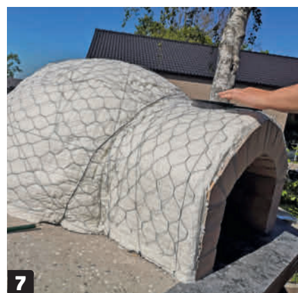
7 Hele den murede ovn isoleres med keramisk isolering, som efterfølgende beklædes med hønsenet, som skal sikre, at pudsematerialet hæfter ordentligt.
