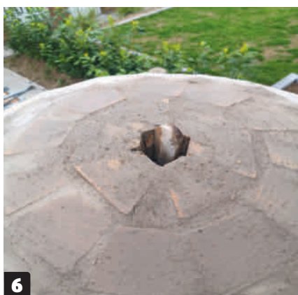
6 Den sidste sten i hver bue skal passe meget nøjagtigt, da det er den sten, der "låser" buen og gør den selvbærende. De sidste sten skæres til enkeltvist, for at kuplen kan "lukkes".
