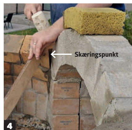
4 Det kan være udfordrende at få den vandrette cirkelform til at passe med den lodrette bue. Hver enkelt sten skal tilpasses individuelt med en vinkelsliber.
