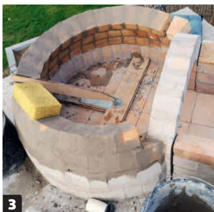
3 For at opnå en præcis og ensartet bue laves en målepind på 45 cm, som fæstnes til centrum med et roterende hængsel.
