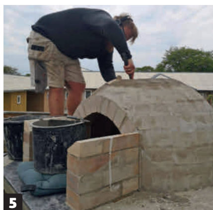
5 Siderne på forkammeret mures med ud. Den øverste sten er skåret skråt, så den følger vinklen på buen. Brug flamingoskabelonen, der også blev brugt til første bue, til at lave resten af buerne på forkammeret.
