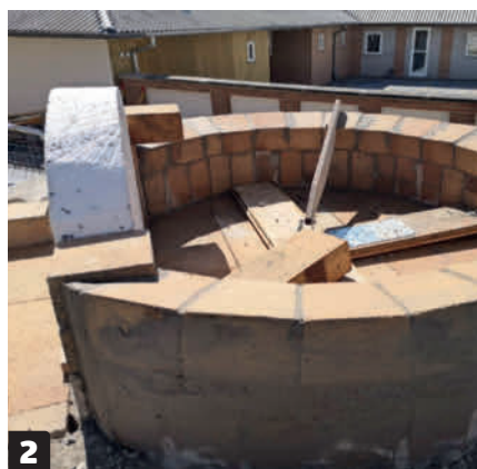
2 En skabelon af flamingo bruges til at danne formen på åbningen ind til ovnen. Åbningen til ovnen skal være 35 % lavere end selve kuplen.
