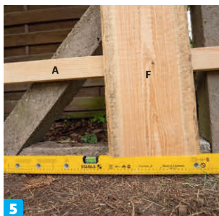
5 Det første villmarkspanelet (F) skrues fast med 5 x 60 mm skruer. I forkant er et langt vater klosset opp på undersiden. Det sikrer avstand til bakken, og at alle bordene kommer til å sitte likt.
