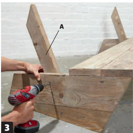
**3** Monter ryggstøttene (A). Forbor før du skrur sammen delene med 6 x 60 mm skruer. Bruker du andre tykkelser enn oss, skal du huske å tilpasse skruelengden, slik at skruene ikke ender med å stikke gjennom.
