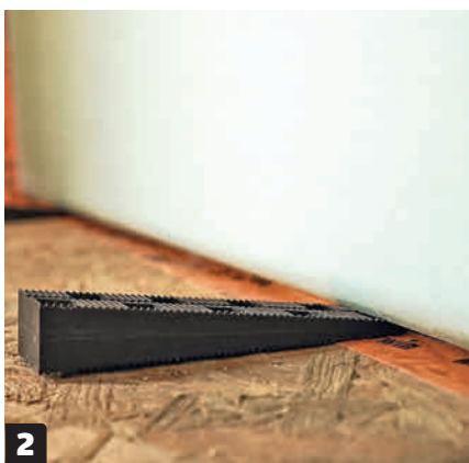
Gipsplatene løftes 3-5 mm fra gulvet, slik at det er plass til at tre og gips kan bevege seg litt. Det er enkelt å løfte platene hvis du plasserer dem på et par kiler.
