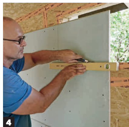
Skjær til gipsplatene, slik at det er åpning til dører og vinduer. Det enkleste er å la platen gå over åpningen, og deretter skjære den til etter at den er skrudd fast.
