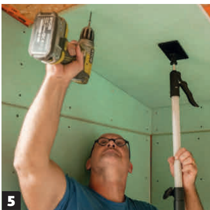
Taket skal også kles med gipsplater. Her får du igjen bruk for en støtte, hvis du ikke har hjelpende hender i nærheten.
