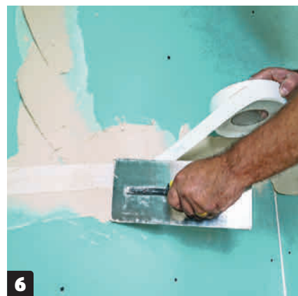
Alle skjøter sparkles og forsterkes med armeringsbånd, som presses godt ned i sparkelmassen. Skruerhullene skal også sparkles, og hele flaten slipes slik at du får en helt jevn flate, som males til slutt.
