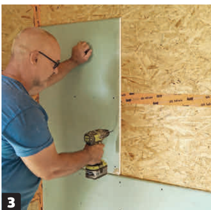
Platene skrus fast. Gipsplatene skal også plasseres litt forskjøvet i forhold til hverandre. Det gir det sterkeste resultatet.
