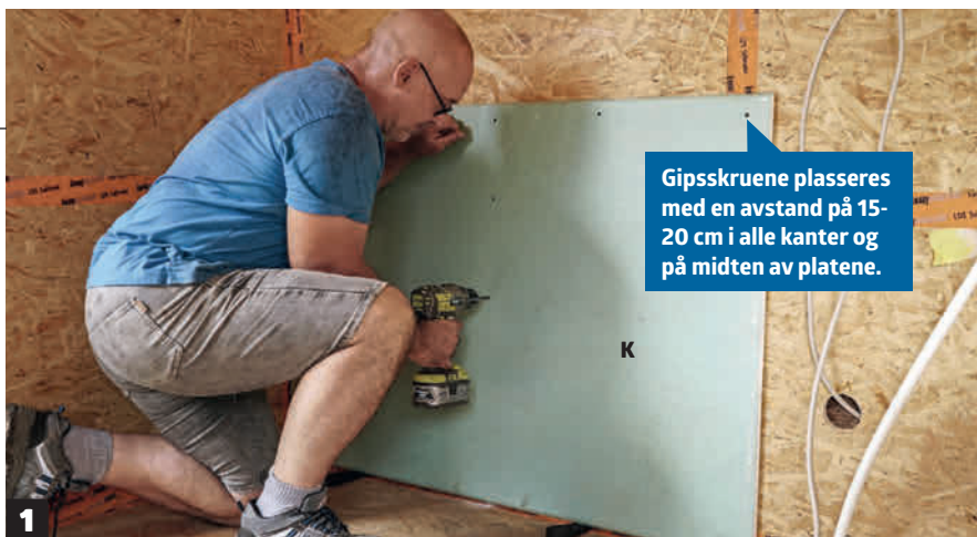
Sett gipsplater (K) utenpå OSB-platene på innsiden. De skrus fast med gipsskruer, som i prinsippet kan plasseres hvor som helst, ettersom det er OSB-plater som underlag.
