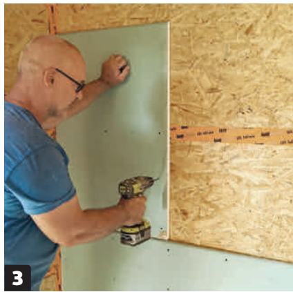
Levyt ruuvataan kiinni. Kipsilevyt tulee myös asettaa hieman limittäin. Siten saat tehtyä lujan rakenteen.
