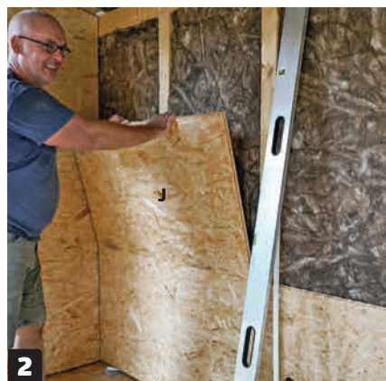
2 Seuraava OSB-levyjen rivi asennetaan. Se asennetaan limittäin niin, etteivät liitokset osu samaan kohtaan kuin alemmassa rivissä. Saat luonnollisen limityksen, jos aloitat rivin palasella, jonka katkaisit edellisen rivin lopusta.
