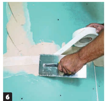
Kaikki saumat tasoitetaan saumamassalla ja vahvistetaan saumanauhalla, joka painetaan kiinni tasoitteeseen. Ruuvireiät on myös tasoitettava ja koko levyn pinta on hiottava, jotta saadaan täysin tasainen ja maalattava pinta.
