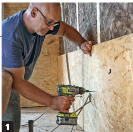
1 Aseta OSB-levyt (J) eristeen päälle.
