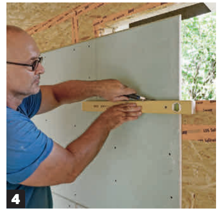
Katkaise kipsilevyt siten, että ovien ja ikkunoiden kohdalle jää aukkoja. Helpointa on peittää aukko ensin levyllä ja leikata levyä pois vasta kiinni ruuvaamisen jälkeen.
