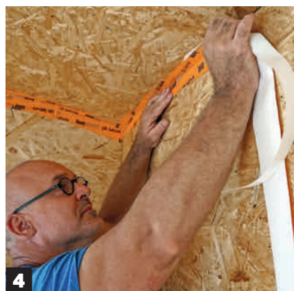
4 Kaikkien levyjen reunat tiivistetään teipillä. Se estää vedon ja myös kosteuden pääsyn rakenteisiin sisäpuolelta.
