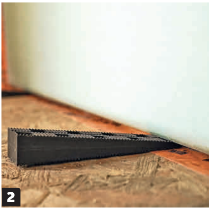
Kipsilevyt kohotetaan 3–5 millii irti lattiasta, jotta koalauspuut ja kipsilevyt pääsevät liikkumaan hieman. Levyt on helppo nostaa, kun ne asetetaan muutaman kiilan päälle.
