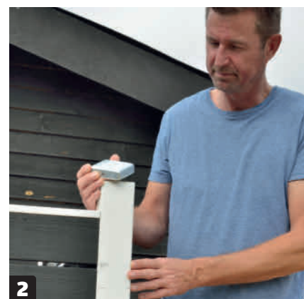
2 Giv alle tre stolper en stolpehat i toppen. På den måde sikrer du, at regnvand og dug ikke med tiden trænger ned i og ødelægger stolperne.
