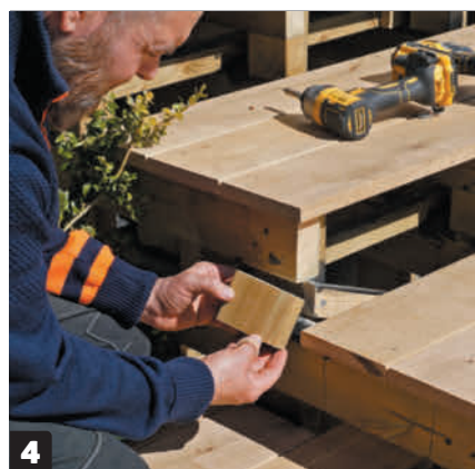
4 Kiinnitä palikat niille sivuille, joille terassilautoja asennetaan pystyyn. Palikat tukevat lautoja ja mahdollistavat niiden kiinnittämisen.
