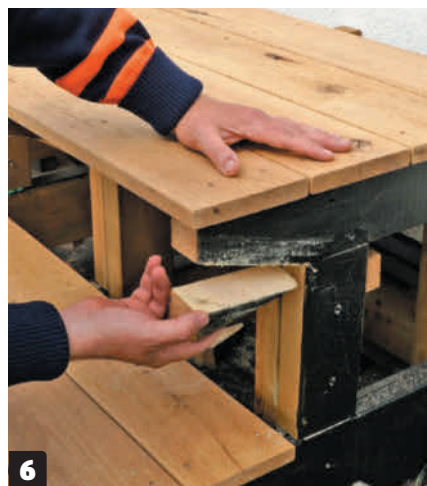
6 Sahaa lopuksi rimojen kulmat penkin alta. Se luo tavallaan kevyemmän vaikutelman ja tekee rakenteesta tyylikkäämmän.
