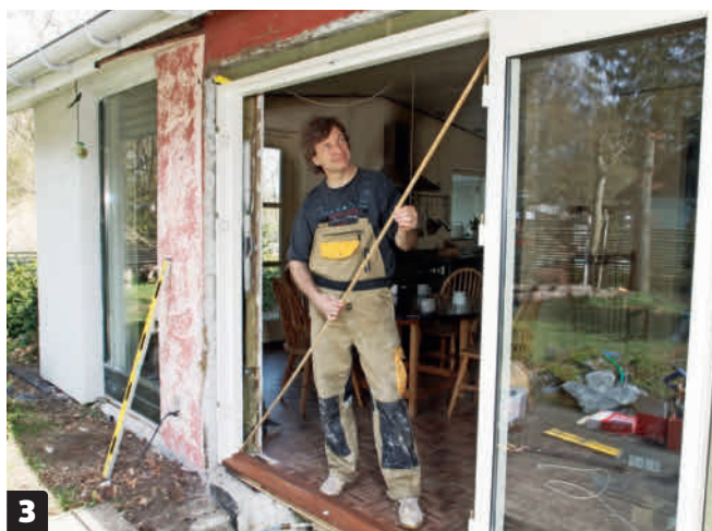
3 Tarkistamme kulmien suoruuden mittaamalla viistosti kulmasta kulmaan. Voit käyttää tehtävään mittaa. Tässä käytetään kahta listaa, jotka työnnetään kulmiin ja painetaan yhteen.
