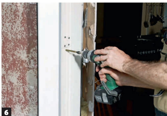
6 Kiinnitämme karmin kokonaan 8 cm:n karmiruuveilla ja laitamme ruuvit kaikkien saranoiden lähelle. Kiiloja voi käyttää välissä, jos ruuvit vetävät karmia kohti seinää. Kiinnitä karmin ylä- ja alaosa vähintään yhdellä ruuvilla pystysuuntaisten karmien kummaltakin puolelta.
