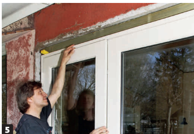
5 Nostamme sitten ovet paikalleen. Tarkistamme vielä, että ovet liikkuvat esteettä. Niiden molempien on sulkeuduttava samanaikaisesti, ja ylä- ja alakarmin ympärillä on oltava yhtä paljon tilaa.
