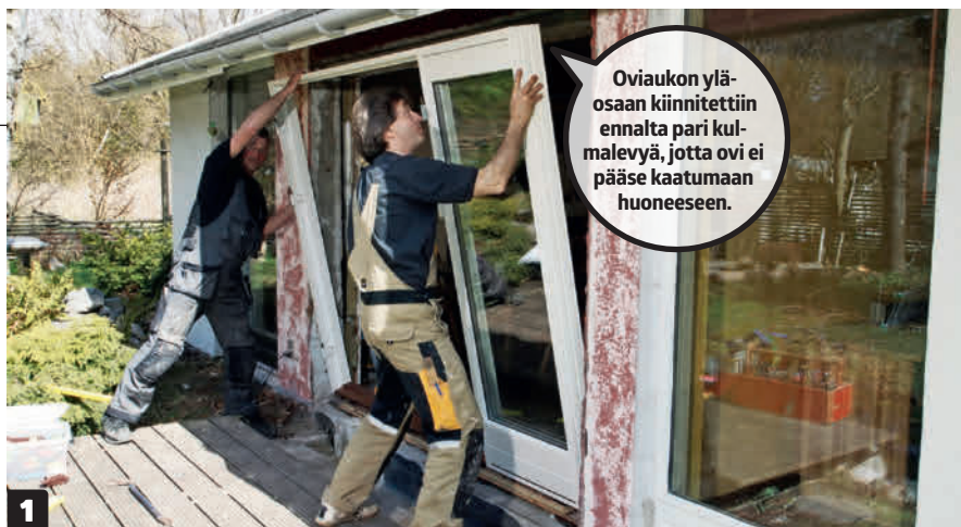
1 Ovien karmiosat nostetaan paikalleen ilman ovia. Kaksi ihmistä tarvitaan nostamaan karmi paikoilleen lattiaan ruuvattujen säätöpalikoiden päälle.
