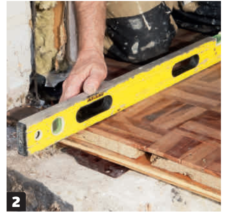
2 Suoristamme lattian kiiloilla siten, että se on vaakasuorassa oviaukon kohdalla. Kiilat painetaan betoniperustan ja aluslattian väliin, jolloin ne kohottavat lautta.
