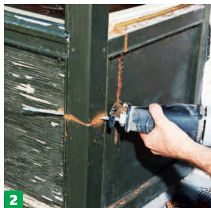
2 Kiinteä ikkuna sahataan irti. Käytämme puukkosahaa ikkunan irrottamiseen. Ikkunan alta sahataan 15 cm viistosti alhaalta ylöspäin, jotta lasiruutu on helppo nostaa pois.
