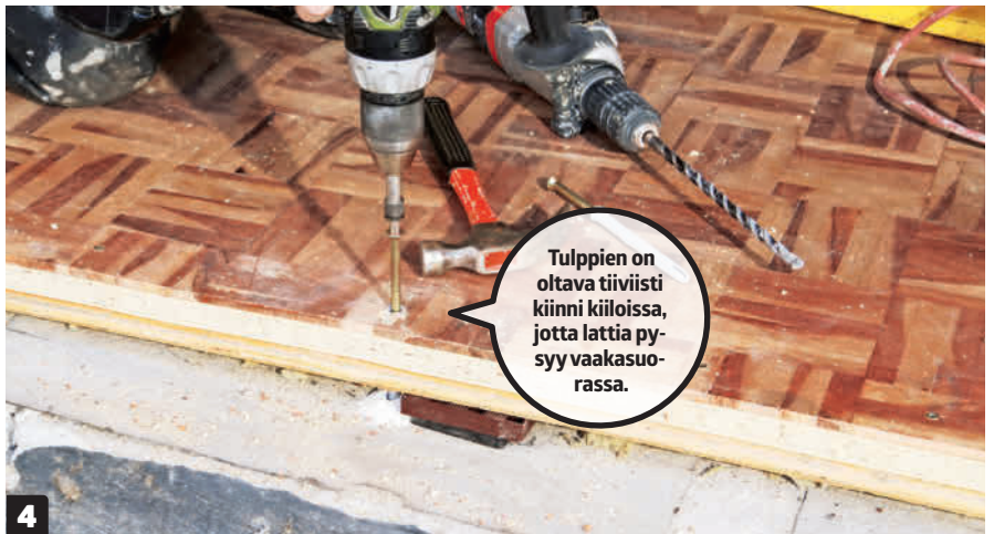
4 Kiinnitämme lattian kuudella 10 mm naulatulpalla, joille poraamme reiät betonilattiaan kiinnittämistä varten. Niitä lyödään alaspäin, kunnes tulpan kaulus on lattian yläreunan tasalla, ja lopuksi tulpat kierretään kiinni porakoneella.
