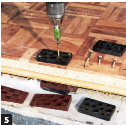
5 Varmistaaksemme sopivan liitoksen oven alla ruuvaamme 10 mm paksuiset muovipalikat lattialle juuri oviaukon kohdalle.
