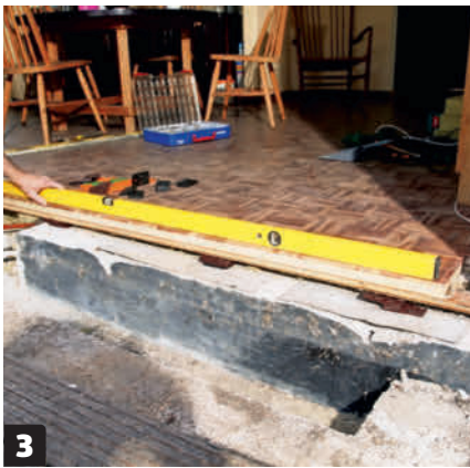
3 Sitten lattia suoristetaan kiiloilla oviaukon kohdalla. Lattian on oltava vaakasuorassa molempiin suuntiin, joten hienosäädämme vielä lattian alle työnnettyjä kiiloja.
