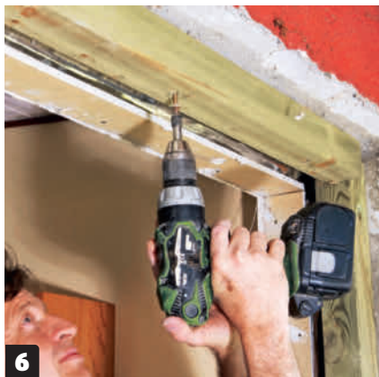
6 Seinässä oleva oviaukko on hiukan liian suuri. Purkamisen yhteydessä kävi ilmi, että oviosa on 75 mm liian pieni. Siksi pienennämme aukkoa kiinnittämällä 73 mm paksun riman sekä ylhäälle että toiselle sivulle.
