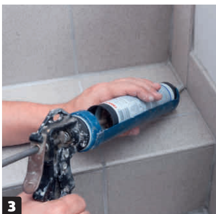
3 Legg silikon i kantene. Når mørtelfugene er tørre, trekker du en stripe silikonfugemasse i overgangen mellom trinnene og kantflisene, slik at de blir ekstra tette.
