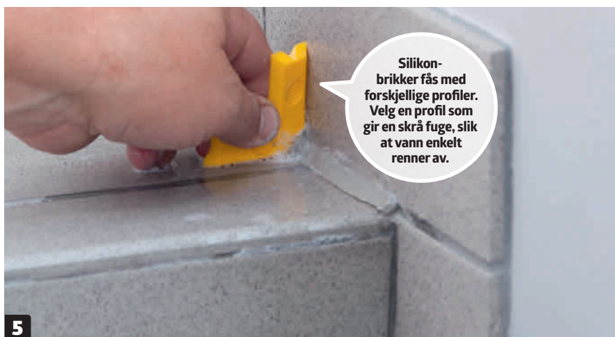
5 Trekk av silikon med en glattepinne eller – som her – med en silikonfugebrikke. Husk å ha litt tørkepapir i nærheten, for silikonfugemasse har en evne til å sette seg på de underligste steder.
