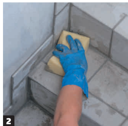
2 Vask fugemasse av flisene med en svamp og rent vann. Rens svampen i et spann, og vri den opp i et annet. Vær forsiktig, så du ikke river opp fugene når du vasker. Fjern kalkslør med eddikvann etter et par timer.
