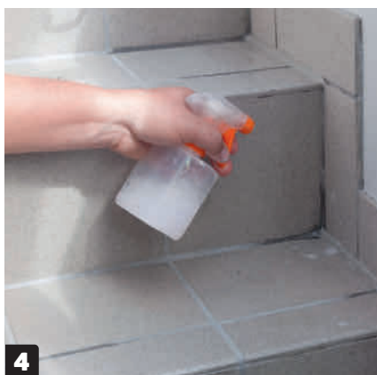
4 Sprøyt såpevann på silikonfugemassen, før du pynter på den. Da unngår du at silikonfugemassen setter seg på flisene når du trekker den av.
