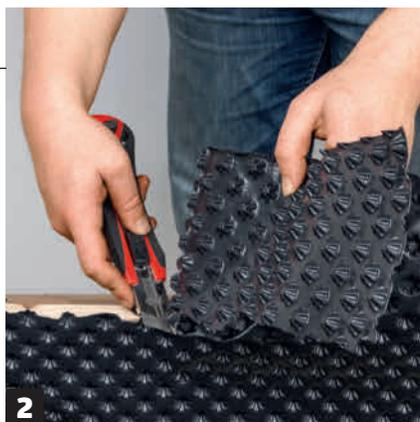
**2** Skjær av plasten i toppen, slik at den flukter med overkant av plantekassen. Det gjøres enkelt med en skarp hobbykniv.
