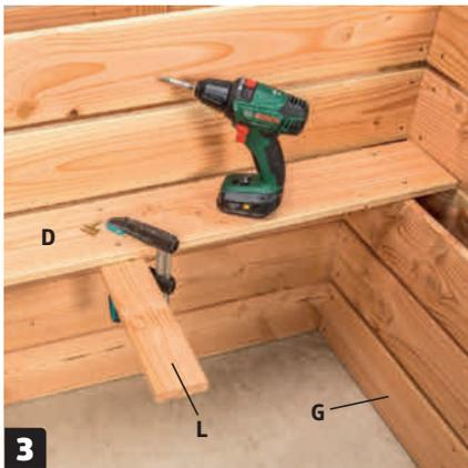
**3** Første setebord (D) skrur fast, og en midtstiver (L) til setet holdes fast med en skrutvinge, før den skrur fast. Fortsett med de øvrige setebordene. Merk deg at de skrur ned i kanten av sidestykkene (G).
