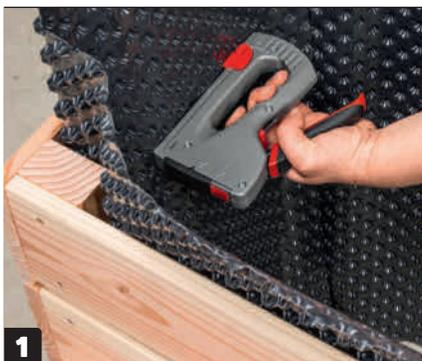
**1** Plantekassen skal tettes, slik at jorden holder seg inne i kassen og ikke ødelegger treet. Bruk knotteplast, og sett den fast med en stiftepistol. Det skal ikke være plast i bunnen, der vann skal kunne renne ut.
