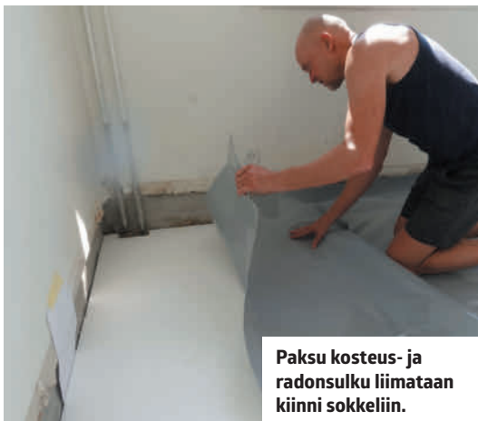
Styroxilevyt asennettiin limittäin, jotta lämpö ei karkaa niiden välistä.
