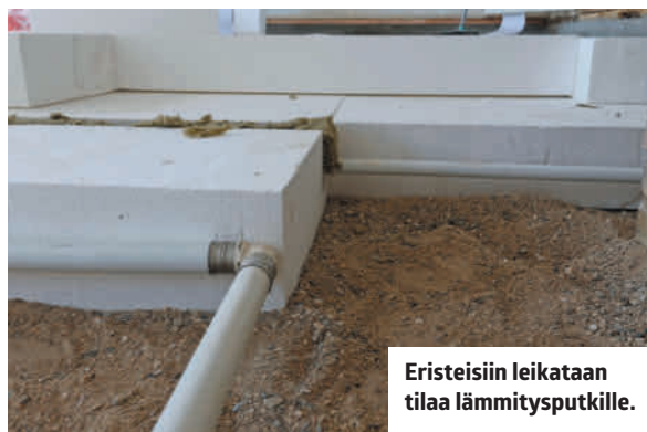
Pidä huoli siitä, että eristeet ovat suorassa.
