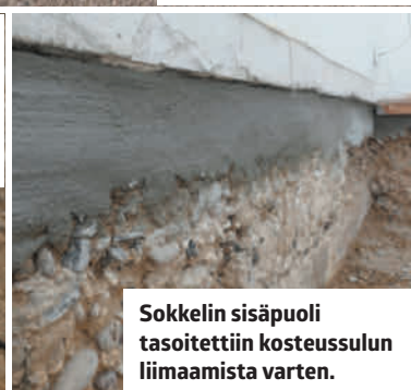
Murske tiivistettiin useassa otteessa tärylevyllä eli lätäkällä.
