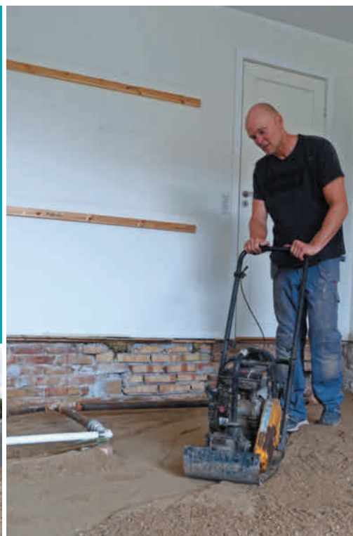
Murske tiivistettiin useassa otteessa tärylevyllä eli lätäkällä.
