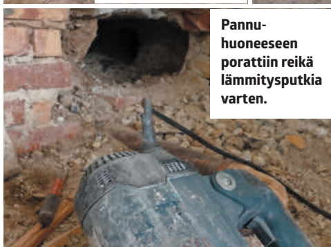
40 neliön kokoiseen lattiaan karrattiin 13 tonnia mursketta.
