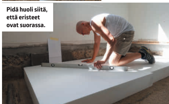
Eristeisiin leikataan tilaa lämmityspotkille.
