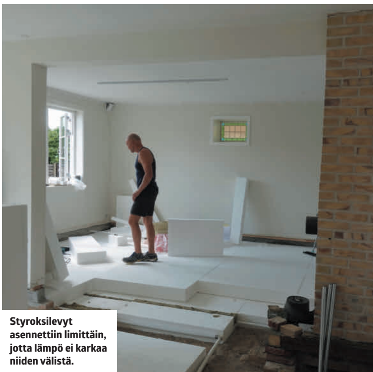
Pidä huoli siitä, että eristeet ovat suorassa.
