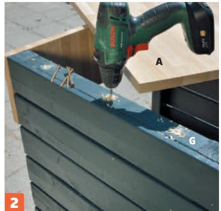
**2 Forbor til skruer i de øverste sideramme-listene (G).** Bruk et 5 mm bor, og skru deretter 5 x 60 mm skruer gjennom rammene nedenfra og opp i benkeplaten (A).
