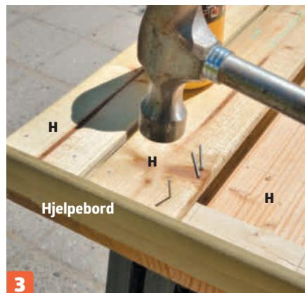
**Spikre bordene (H) på rammene.** Smør på lim, og spikre med 1,7 x 40 mm dykkert. Skru først et hjelpebord på siden av rammen, og la det stikke litt opp over kanten, slik at bordene (H) kan støtes mot det.
