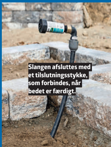
Den særligt stive PVC-vandslange nedgraves og føres op midt i bedet.
