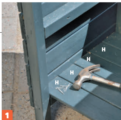
1 Naulaa hyllylaudat (H) kiinni poikki-rimoihin (G) 1,8x40 millin nauloilla.
