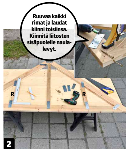
2 Kokoa kolmiot 5x80 millin ruuveilla, 40x120 millin naula-levyillä ja 4x20 millin ruuveilla.
