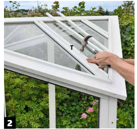
Naulaa lasilistat (T) kiinni varovasti kattorunkoihin 12x25 millin nauloilla.
