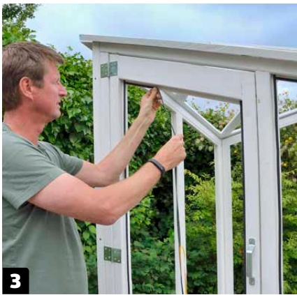
Liimaa kittinauhaa kasvihuoneen kaikkiin huulloksiin, asenna lasit paikoilleen ja naulaa listat niiden päälle.
