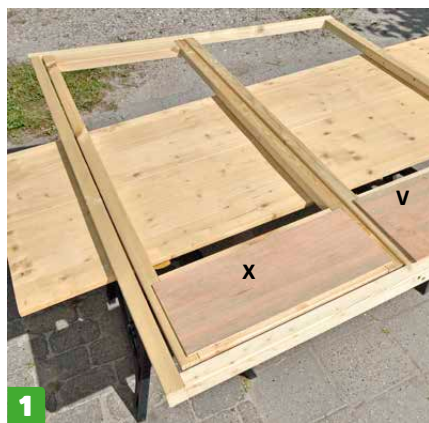
1 Naulaa vanerilevyt kiinni seinärunkoihin ja ovielementtiin 18x35 millin nautoilla. Kuvassa näkyvät lyhyet levyt (X ja V).
