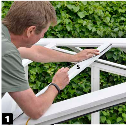
Kiinnitä itseliimautuva kittinauha huullosrimoihin (S) ja laske lasi varovasti paikalleen.
