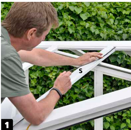
1 Sätt självhäftande fogband i falsarna (S) på taket, och lägg försiktigt glaset på plats.
