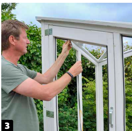
3 Sätt fogband i resten av drivhusets falsar, sätt i fönster, och spika listerna på plats.
