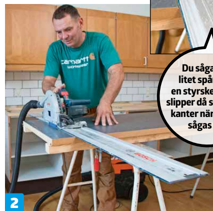
2 Med cirkelsågen sågas ett cirka 3 mm djupt spår.
