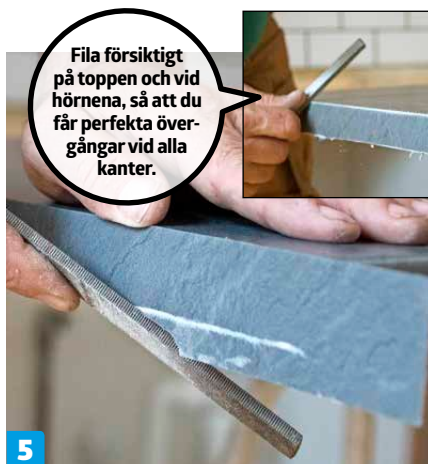
5 Fila vid den nedersta kanten mot bänkens undersida. Fila försiktigt med lugna, glidande drag längs kanten, tills den överflödiga biten lätt kan rivas av.
