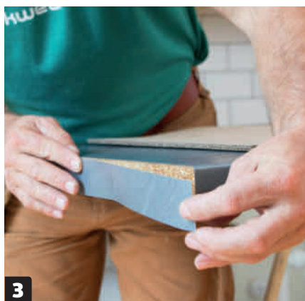
3 Sett på laminatstrimmelen. Gjør deg flid, og sørg for at den øverste kanten flukter nøyaktig med kanten på benkeplaten. Trykk laminatstrimmelen inn mot benkeplaten, slik at limet blir presset godt sammen.
