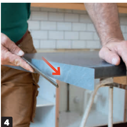
4 Stryk den nederste kanten med en fil eller slipepapir på en slipekloss når limet har satt seg. Lag lange strøk i én retning – da knekker laminatkanten pent langs kanten på benkeplaten.
